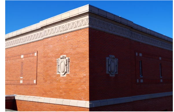
Terra cotta friezes & cornices
